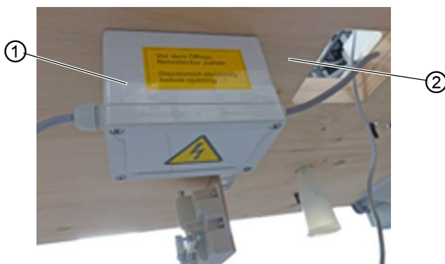
Fig. 66: Монтаж сетевого фильтра
